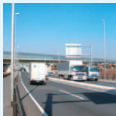
インターチェンジへのアクセス道路(国道122号騎西菖蒲バイパス/久喜市)
