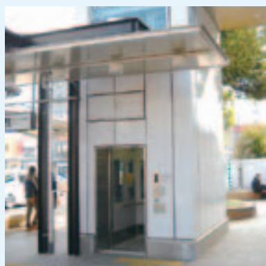
駅バリアフリー施設(蓮田駅)
