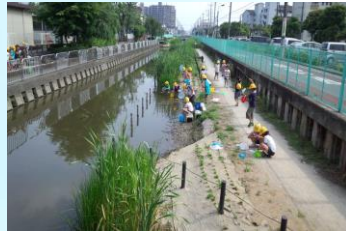
一施設の活用の様子(八潮市) 松の木小学校付近「どんぐり遊歩道」対岸に自然観察広場を整備しました。児童の自然学習等の場として利活用されています。
