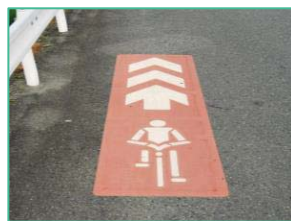
▲道路着色舗装
