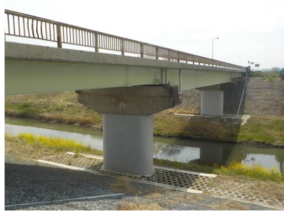
耐震補強を行った農道橋（玉作橋・熊谷市）
