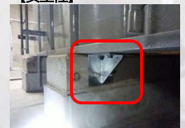
④既設受水槽の耐震化
