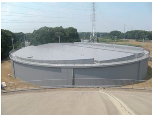
上赤坂中継ポンプ所 PC 送水調整池（狭山市）
