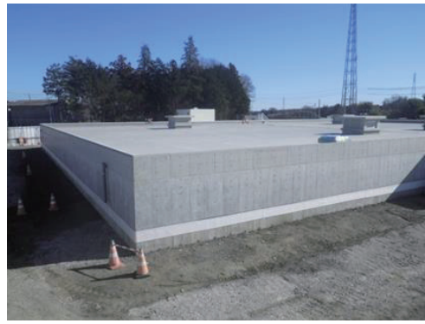
江南中継ポンプ所 RC 送水調整池（熊谷市）
