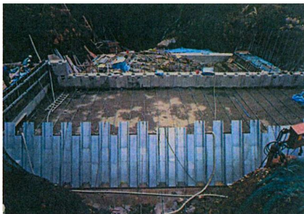
写真Ⅲ- 4-5 中詰め材として現地の土砂砂礫を用いた鋼製砂防堰堤（ダブルウォール堰堤）
