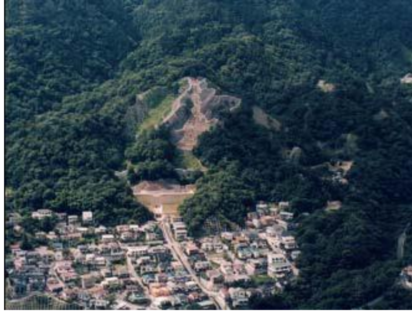
焼ヶ原堰堤（六甲砂防事務所）
