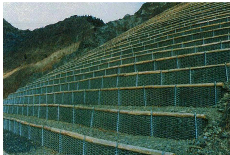
写真Ⅲ- 4-11 柵工の天端に間伐材を利用
