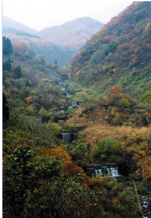
虫川床固工（新潟県）
