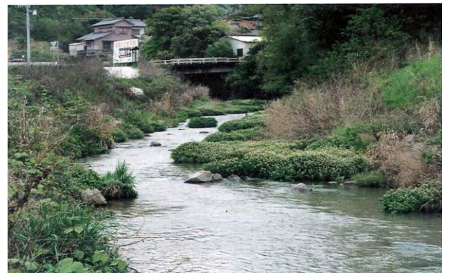
【施工後】 水際にはセキショウやネコヤナギが繁茂
