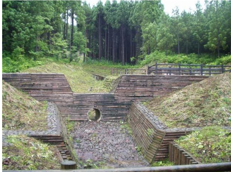
写真Ⅲ- 4-9 砂防堰堤の修景に間伐林を利用
