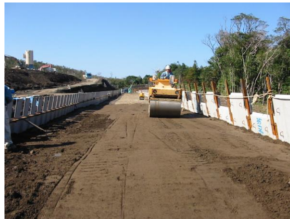
写真Ⅲ- 4-6 現場発生土砂を活用した砂防ソイルセメント工法（INSEM-SBウォール堰堤）
