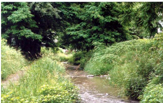
【施工後】 水際には植生が茂り、おだやかな自然の水辺が形成されている。
