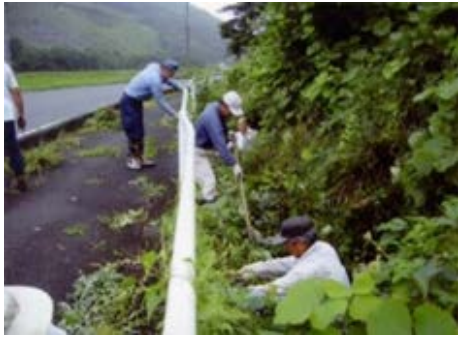
【水路の除草作業】
