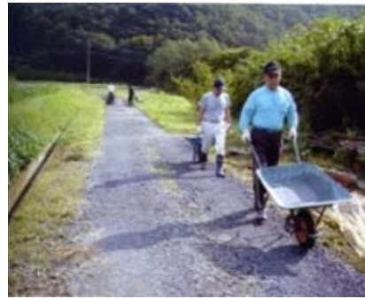
【農道の路面補修】
