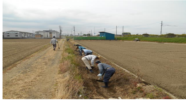
水路の泥上げ
