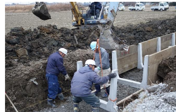
水路更新作業
