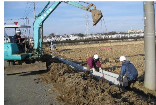
コンクリート水路の新設
