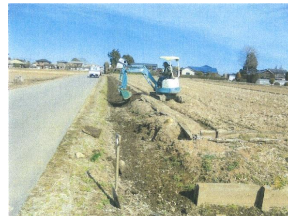
水路浚渫工事
