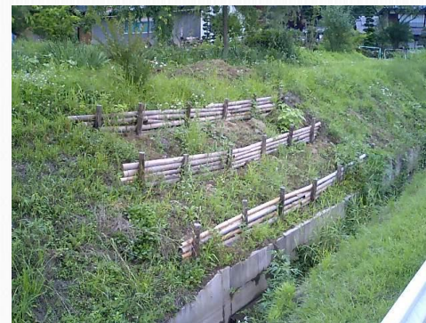
【水路法面の復旧状況】
