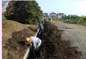
水路の泥上げ
