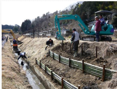
【法面の補修作業】
