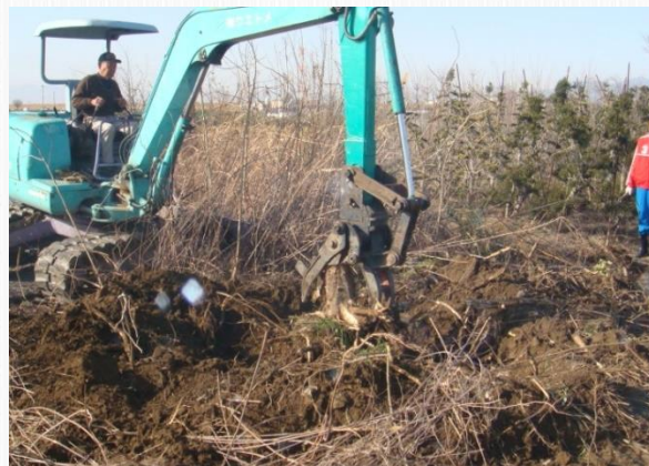
【重機による抜根作業】
