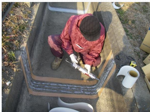
御正堰地域農地・水・環境保全 管理協定(熊谷市)
