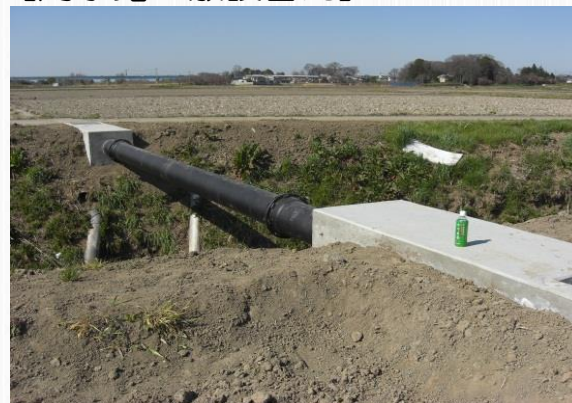
平方西部環境保全会 (上尾市)
