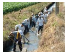
水路の泥上げ
