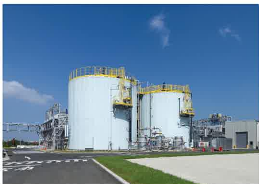
NEFC バイオガスプラント
