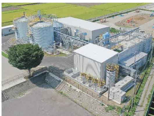
ニューエナジーふじみ野プラント外観
