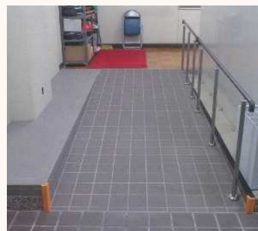
（スロープ整備）
