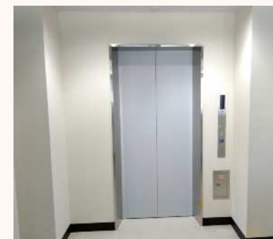
（エレベーター整備）
