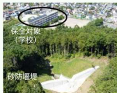
砂防関係施設整備
