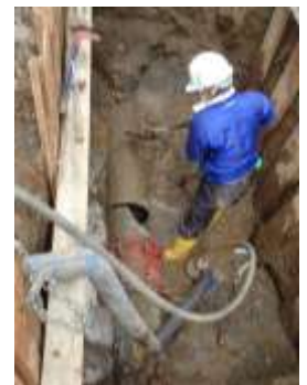
パイプラインの補修
