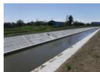
農業用排水路
