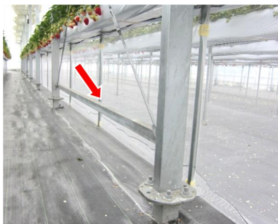
柱と柱の補強（角パイプ）
