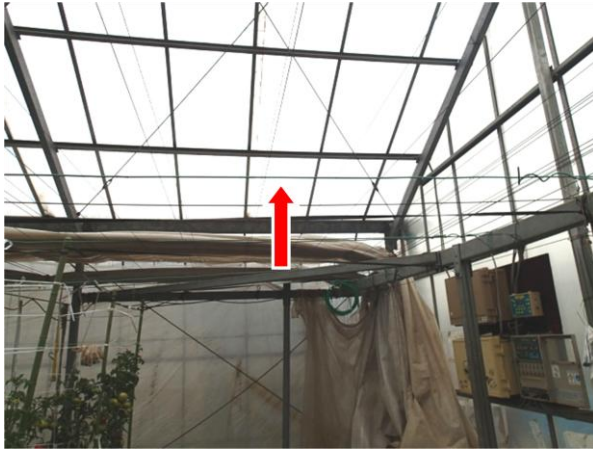
妻面に設置（ワイヤー）
