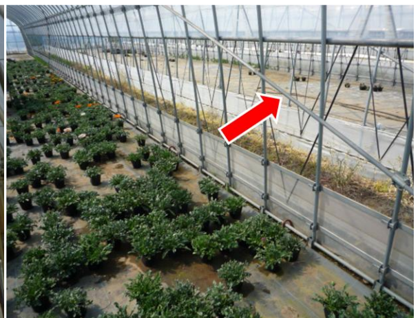
サイド部の補強 (筋交い)
