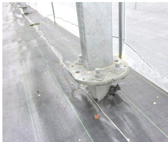
鉄柱基礎（鉄柱打込み：約1m）
