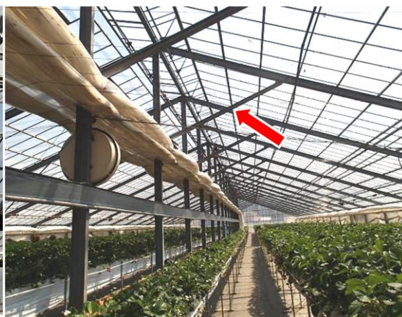
屋根と柱の補強（角パイプ）
