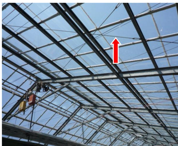
屋根材の補強：X字状に設置
