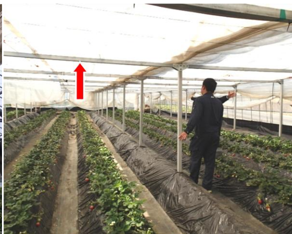
柱材の補強：角パイプ鋼材陸梁
