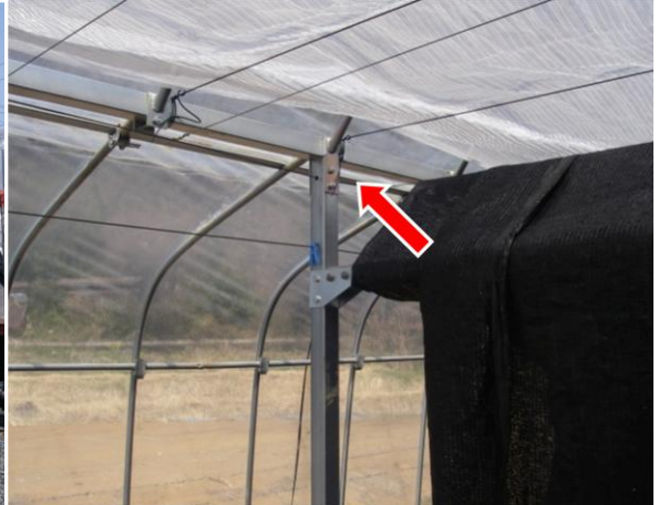
柱と梁を補強
