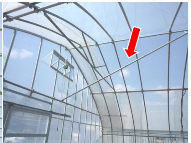
妻面と屋根の補強
