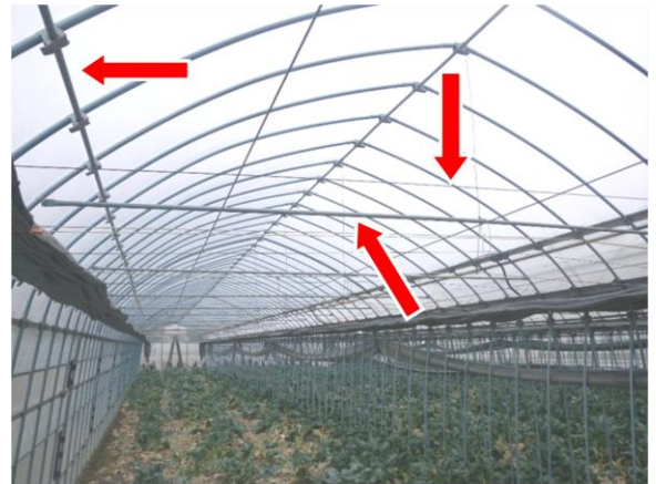
タイバーと屋根と妻面の補強
