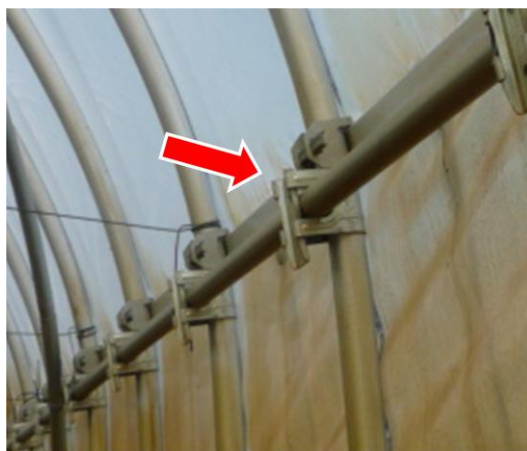
接合金具（鉄板製）
