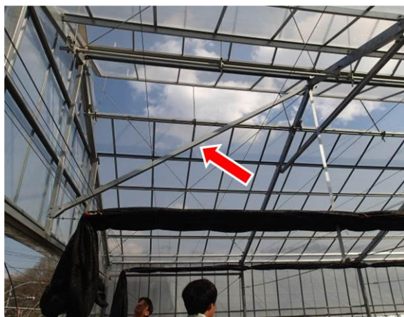
妻面と屋根の補強（角パイプ）
