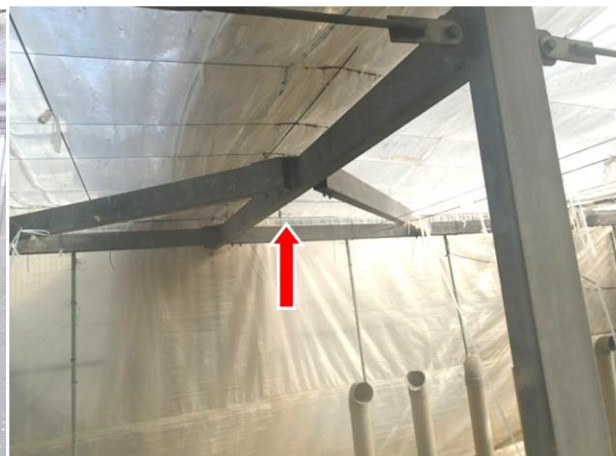
梁と柱の補強（角パイプ）
