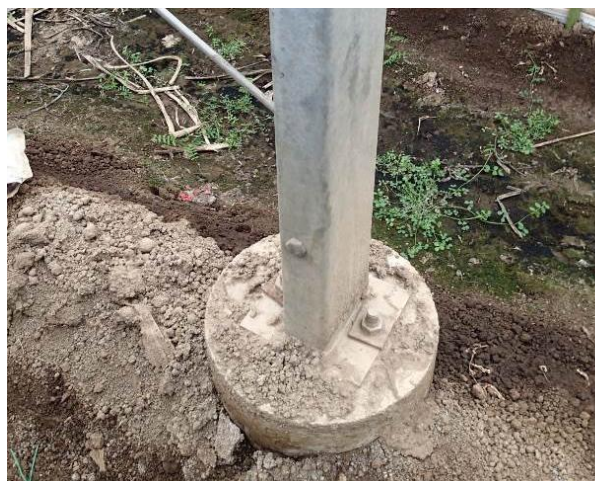
セメントの容積、接地面が大きい
