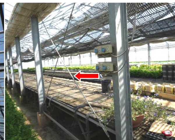
柱材の補強：X状に設置
