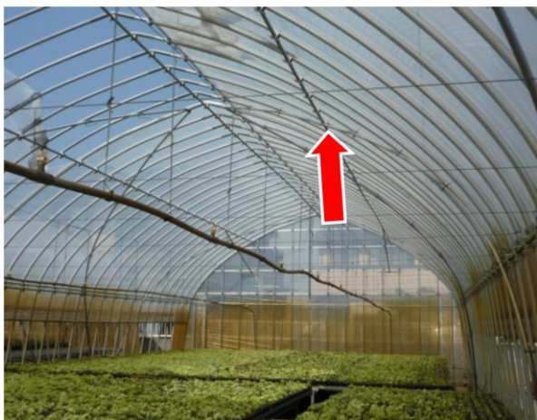
屋根の補強 (母屋パイプ)
