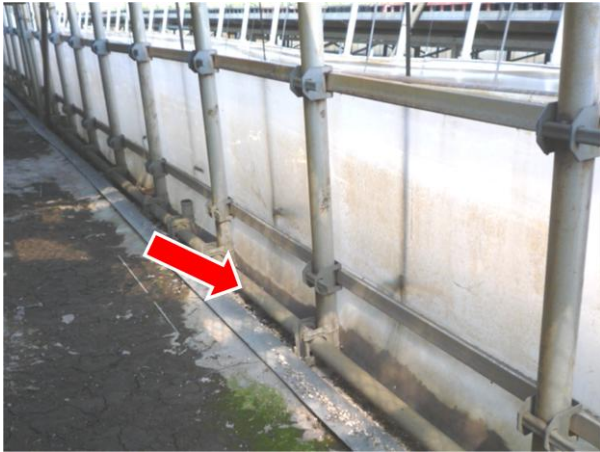
沈下防止パイプ
