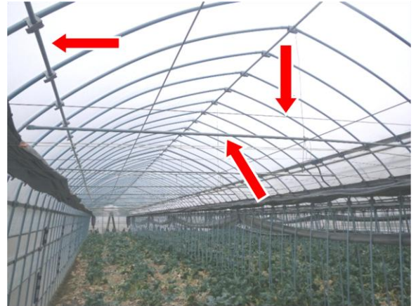
タイバーと屋根と妻面の補強
