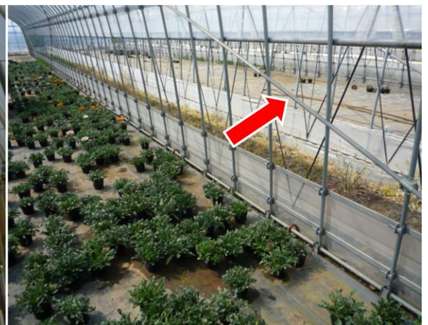
サイド部の補強 (筋交い)
