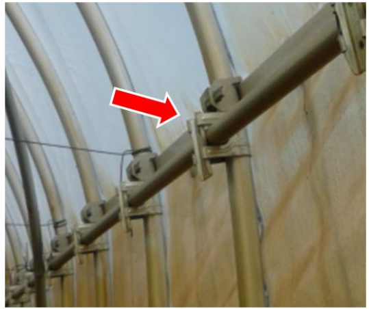
接合金具（鉄板製）
