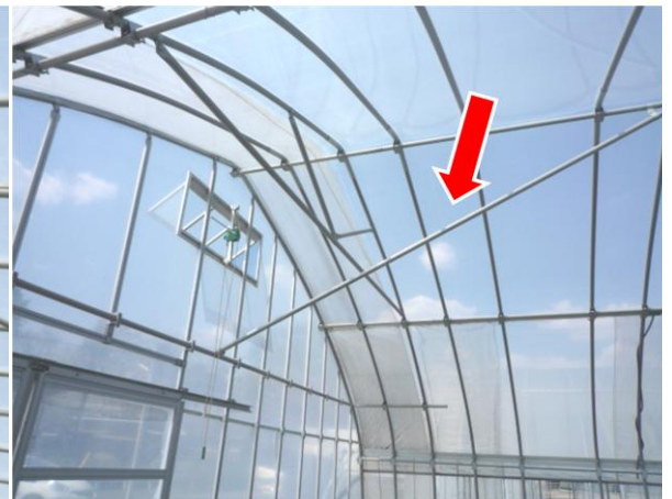
妻面と屋根の補強
