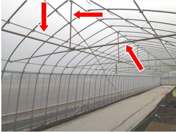
タイバーとワイヤーと母屋パイプ
