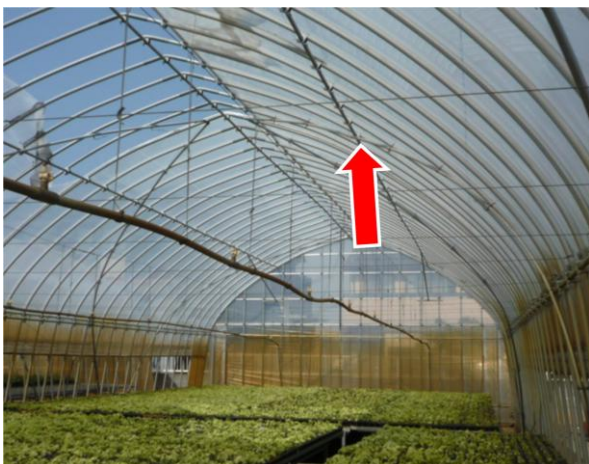
屋根の補強 (母屋パイプ)
