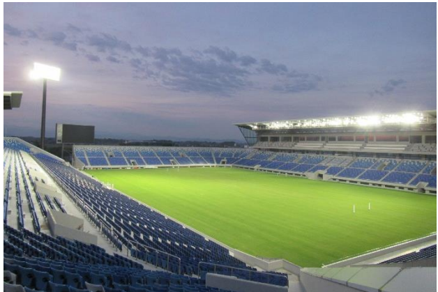
夜間試合が可能な LED照明を新設
