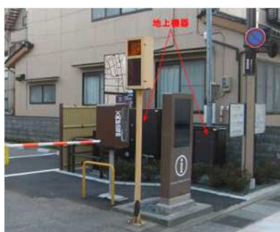
民有地を活用した地上機器の設置 (国土交通省HPより)
