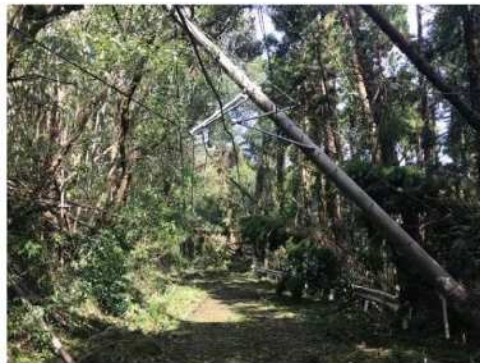
令和元年(2019年)台風15号による山間部における電柱倒壊 (国土交通省HPより)
