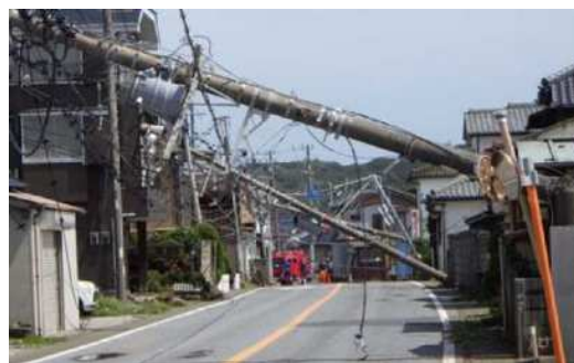
令和元年(2019年)台風15号による 電柱倒壊 (国土交通省HPより)
