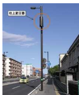
柱状機器の設置 (国土交通省HPより)
