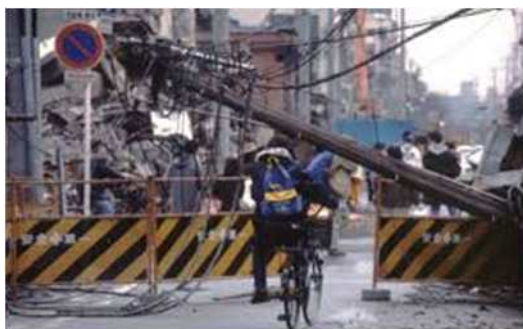
阪神淡路大震災における電柱倒壊 (国土交通省HPより)
