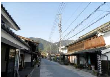
伝統的建造物群にそぐわない電柱 (国土交通省HPより)
