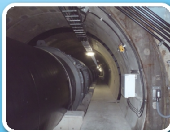
シールド内配管完成
