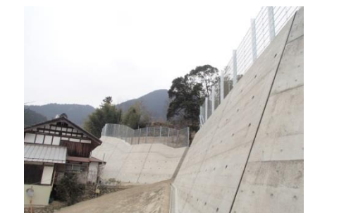
急傾斜地崩壊対策施設
