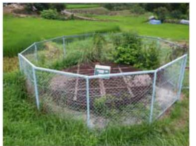
地すべり防止施設
