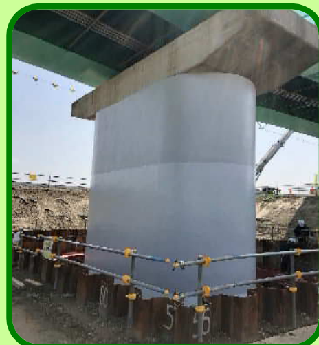
【耐震補強の例】 鴻巣川島線（糠田橋）
