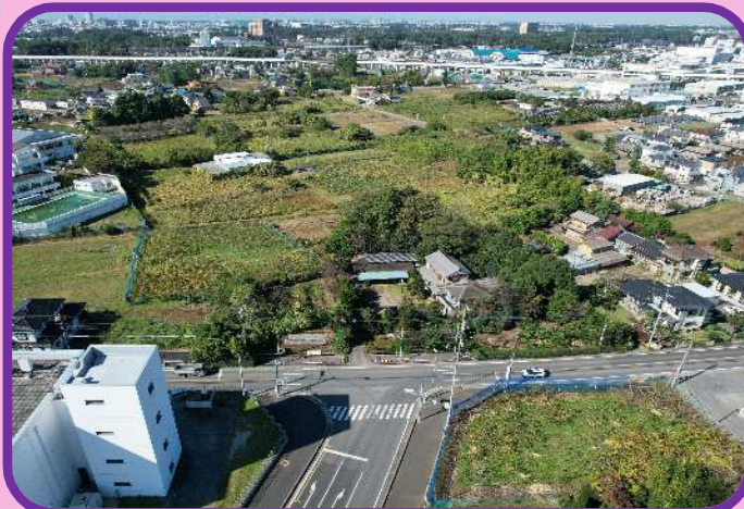
蓮田鴻巣線（小室工区）
