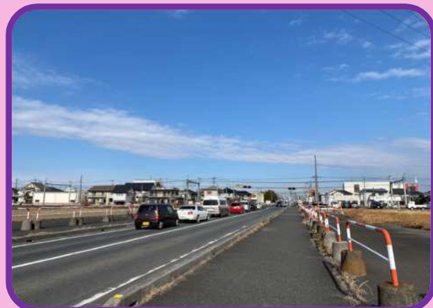
鴻巣川島線 JR高崎線の踏切付近
