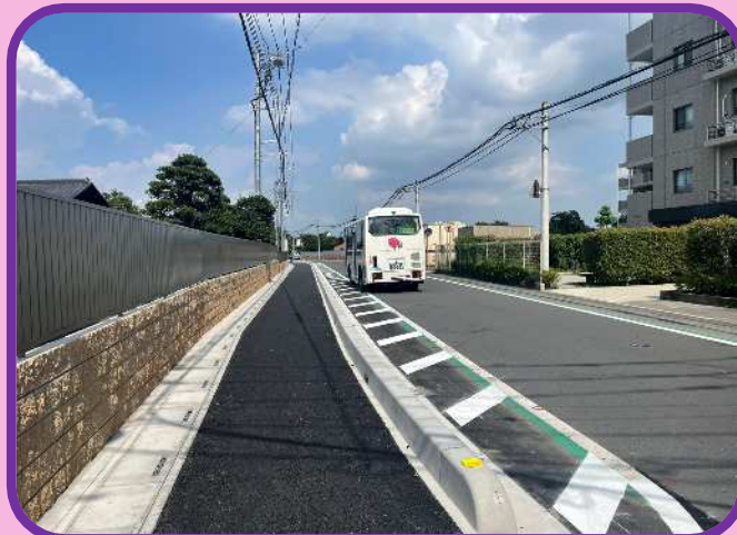
上尾環状線（小室工区）
