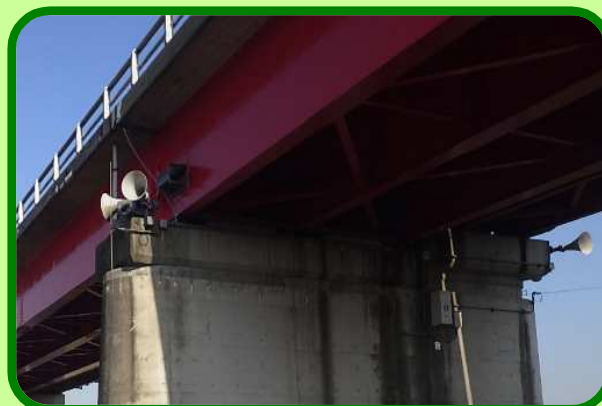
御成橋の塗替え後
