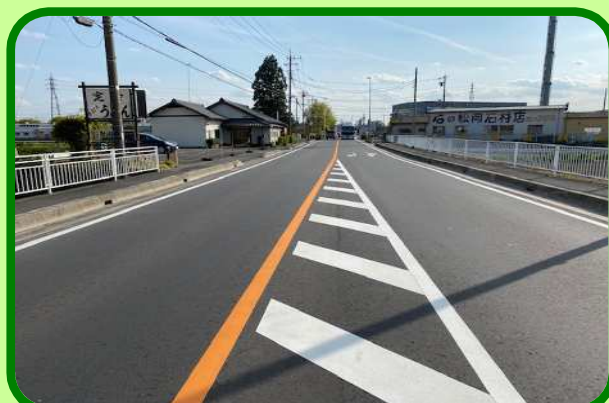
舗装の修繕後
