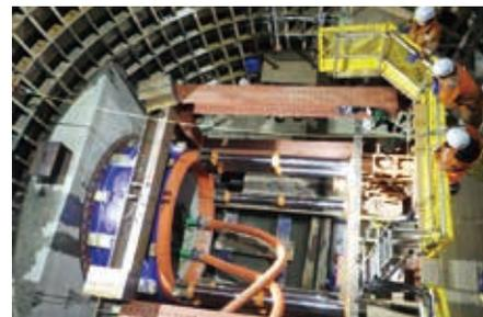
推進工法による着水井原水管布設の様子
