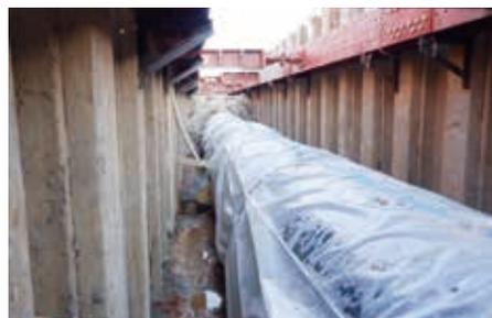
開削工法による送水管布設工事の様子
