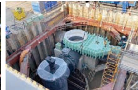
不断水工法による着水井既設管分岐の様子
