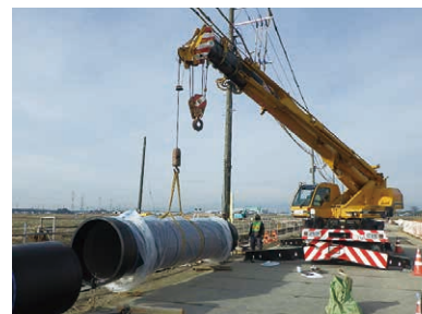
送水管布設工事の様子
