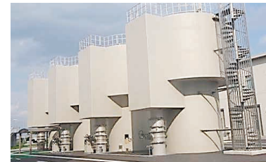
高度浄水処理施設(オゾン接触池)
