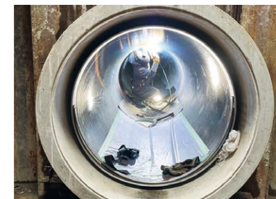
推進工法による管布設工事の様子
