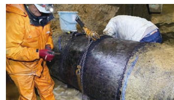
漏水事故対応の様子
