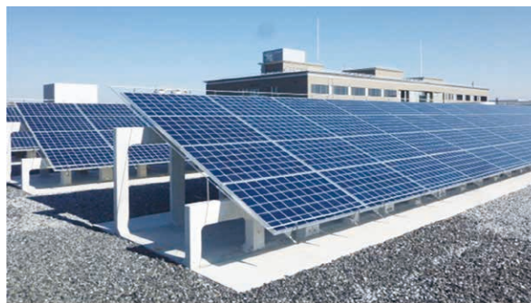
吉見浄水場の太陽光発電設備(発電容量950kW) 平成26年度設置
