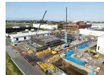
着水井本体築造工事の様子
