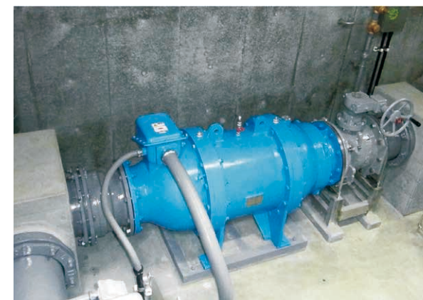
高坂中継ポンプ所の小水力発電設備(発電容量28kW) 平成23年度設置
