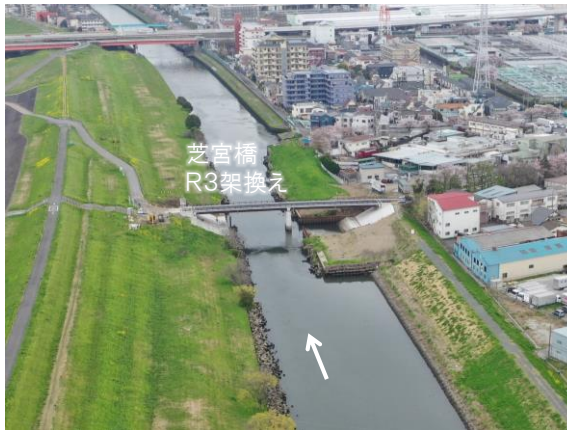
未改修区間（上流から下流を望む）
