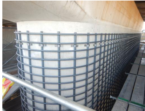
いろは橋の耐震補強
