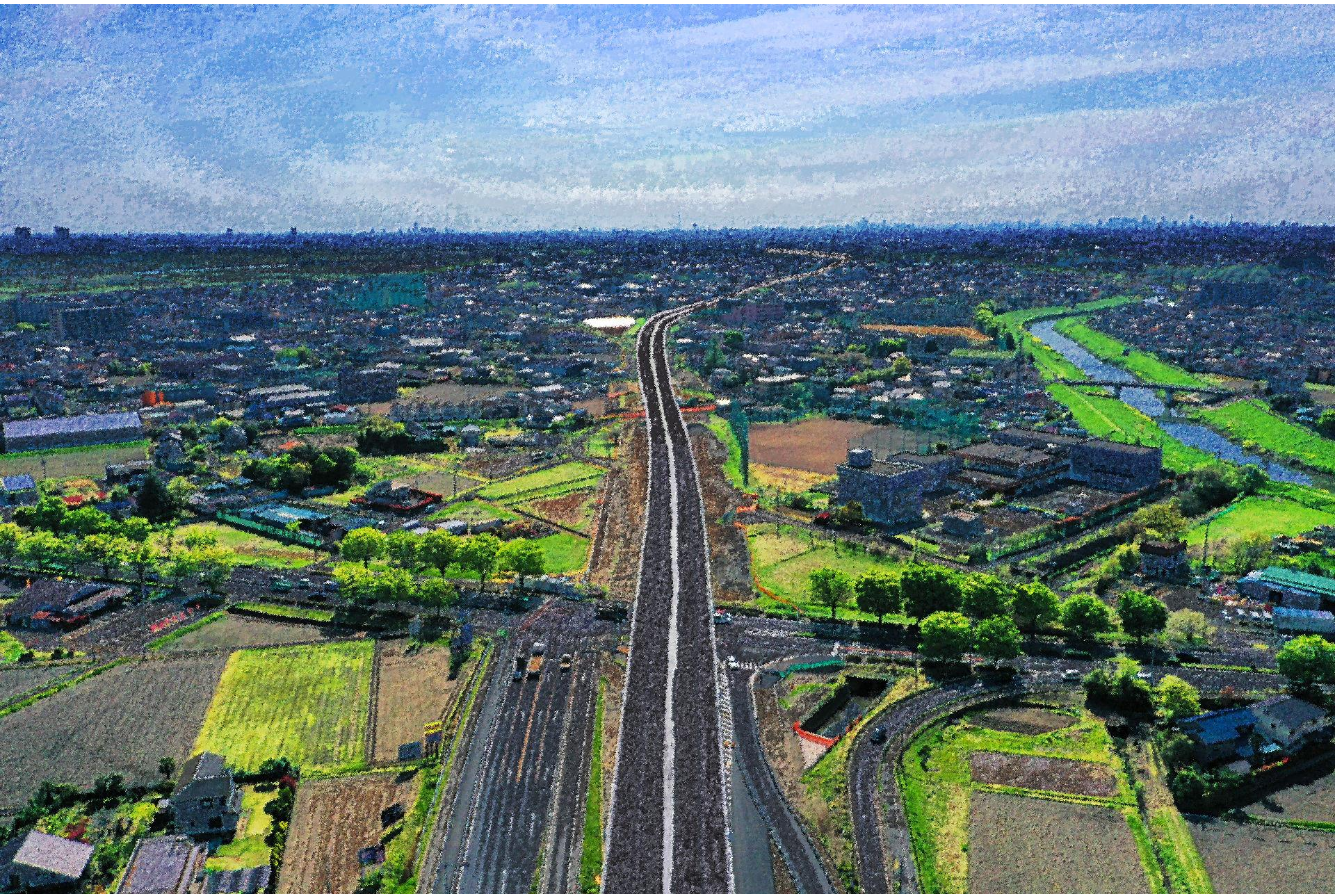
一般国道254号和光富士見バイパス
