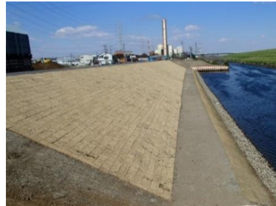
築堤・河道拡幅（整備後）
