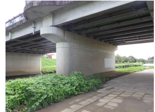
いろは橋の耐震補強
