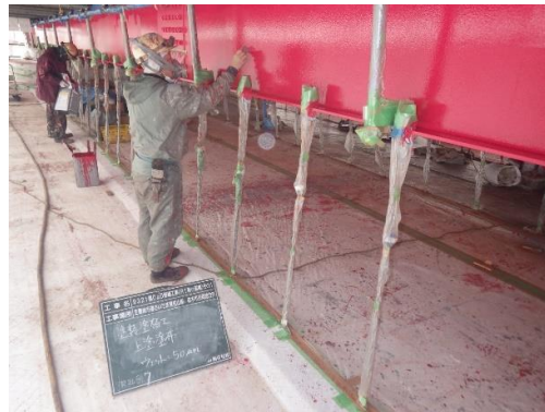
主桁の塗装塗替
