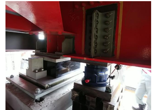
ゴム支承への交換
