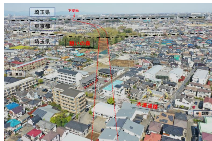
新堀工区：南側から北側を望む
