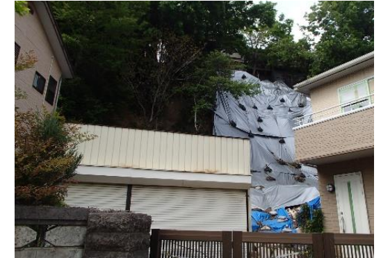
対策箇所状況
