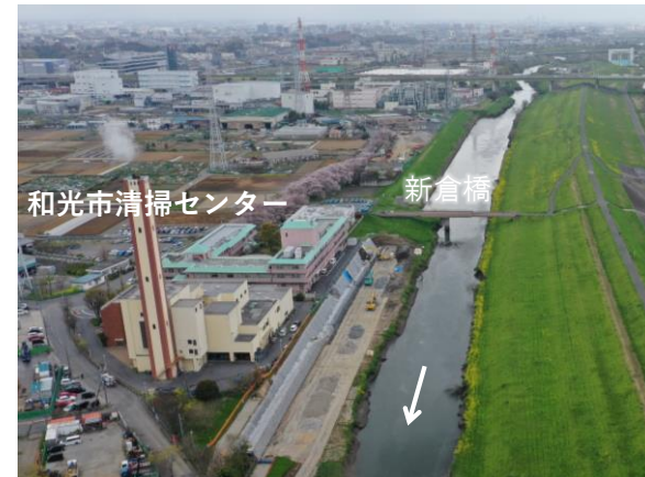
未改修区間（下流から上流を望む）
