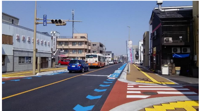
整備済みの中央通停車場線（2工区）
