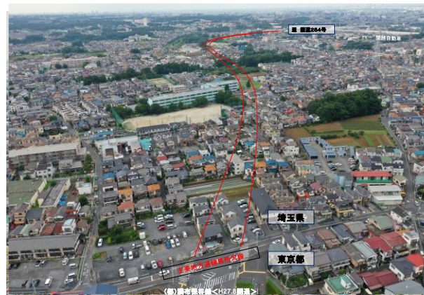
野寺工区：都県境から北側を望む
