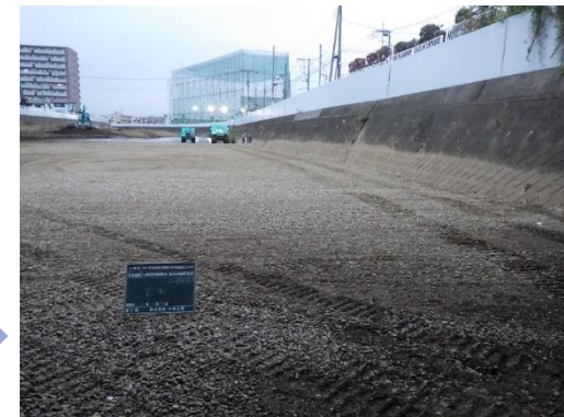
堆積土砂撤去
