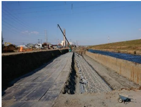
築堤・河道拡幅（整備中）
