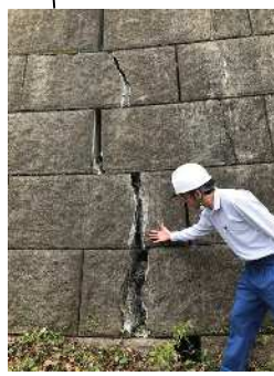
擁壁の損傷
