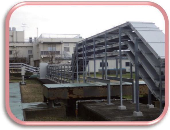
新たに敷設した電路
