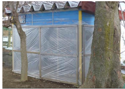
寒冷対策を兼ね、シートを張った野生動物侵入防止対策
