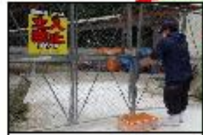
フェンス設置
