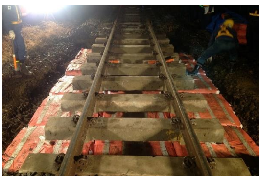
施工例3：鉄道 噴泥対策と振動低減
