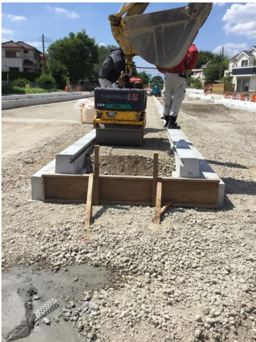
巻込み部施工完成図
