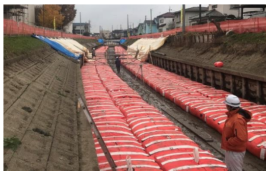
施工例2：水路護岸工事 地盤補強
