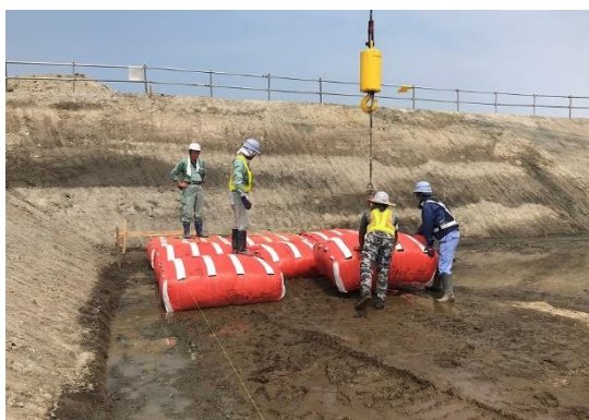
施工例1：ふ頭埋立造成工事 地盤補強と液状化対策
