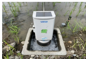
バルブの開閉作業
