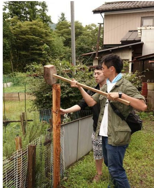
図3 杭をハンマーで打ち込む様子
