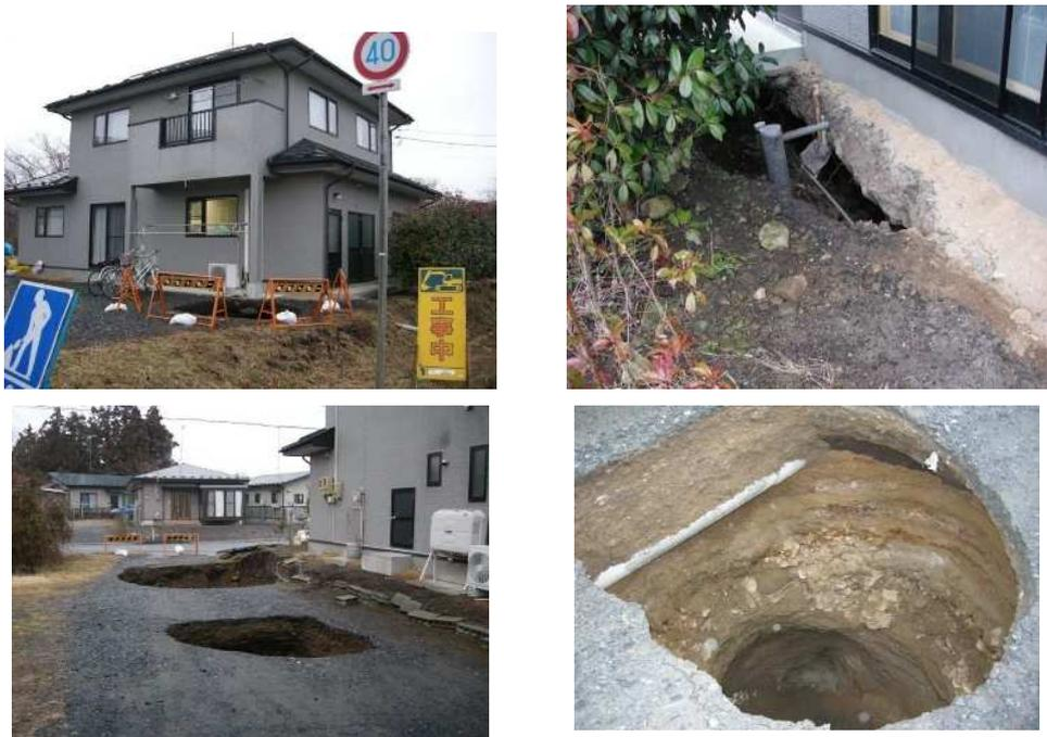
写 3-3 宅地地盤の陥没の例
