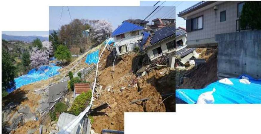
写 3-11 のり面の崩壊の例
