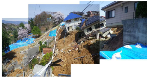
(d)液状化による側方流動の事例
