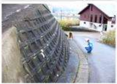
(1) 被害状況確認(擁壁)
