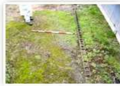
(2) 被害状況確認(宅盤)
