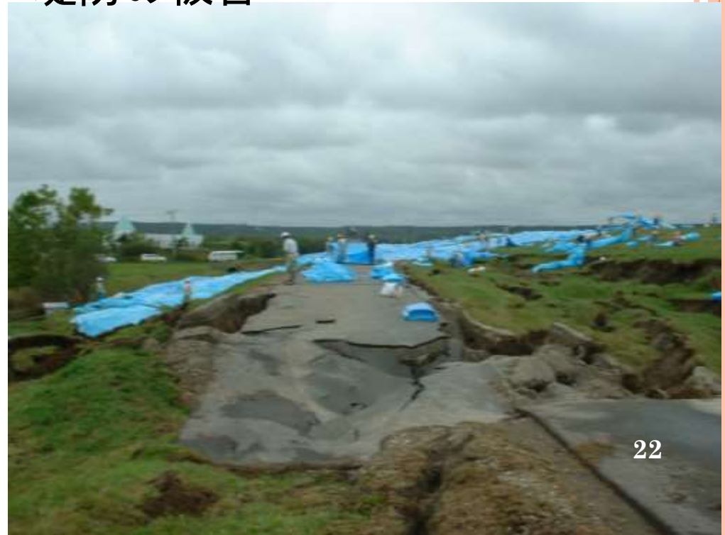
2003年十勝沖地震による十勝川 堤防の被害
