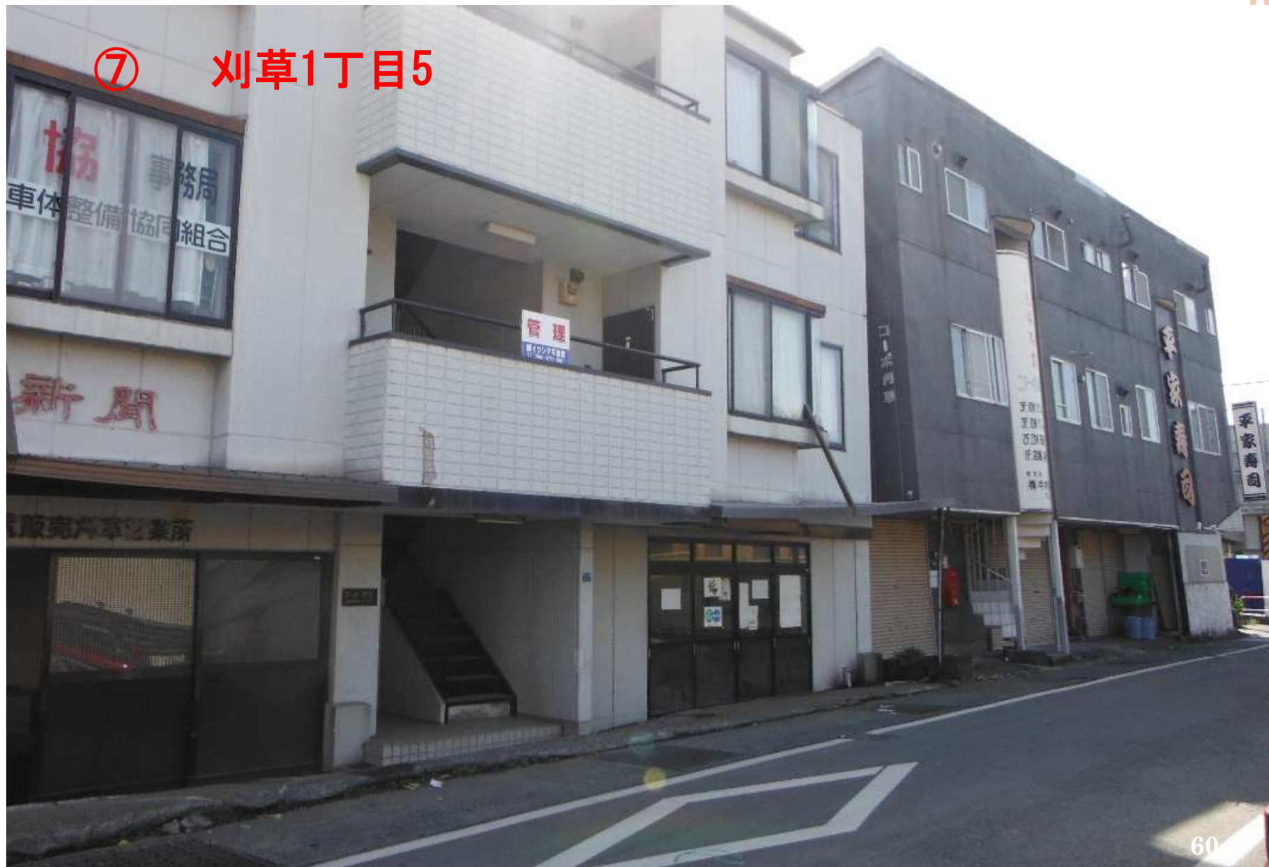
刈草1丁目における液状化被害
