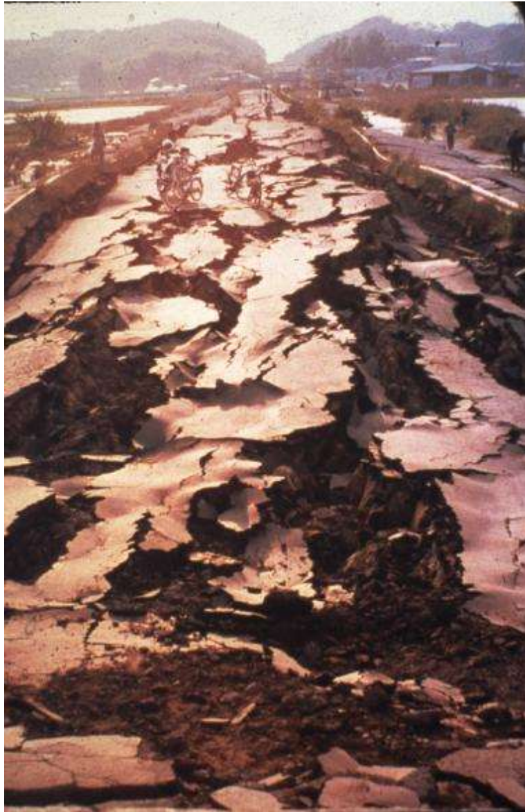
1983年日本海中部地震による八郎 潟干拓堤防とその周辺盛土の沈下
