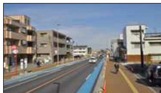
無電柱化の実施状況（保谷志木線）
