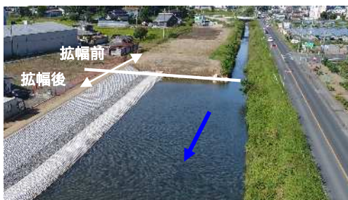
洪水時の水位を低下させるため河道を拡幅
