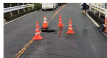
道路の陥没事例
