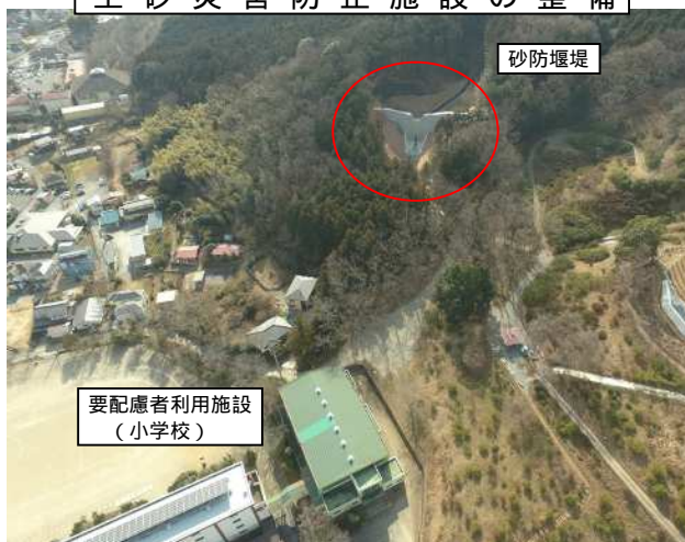
土砂災害防止施設の整備
