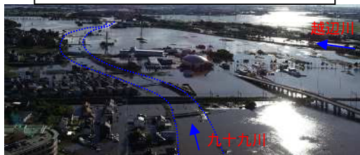
令和元年東日本台風被災状況
