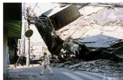
阪神・淡路大震災 出典：(一財)消防防災科学センター
