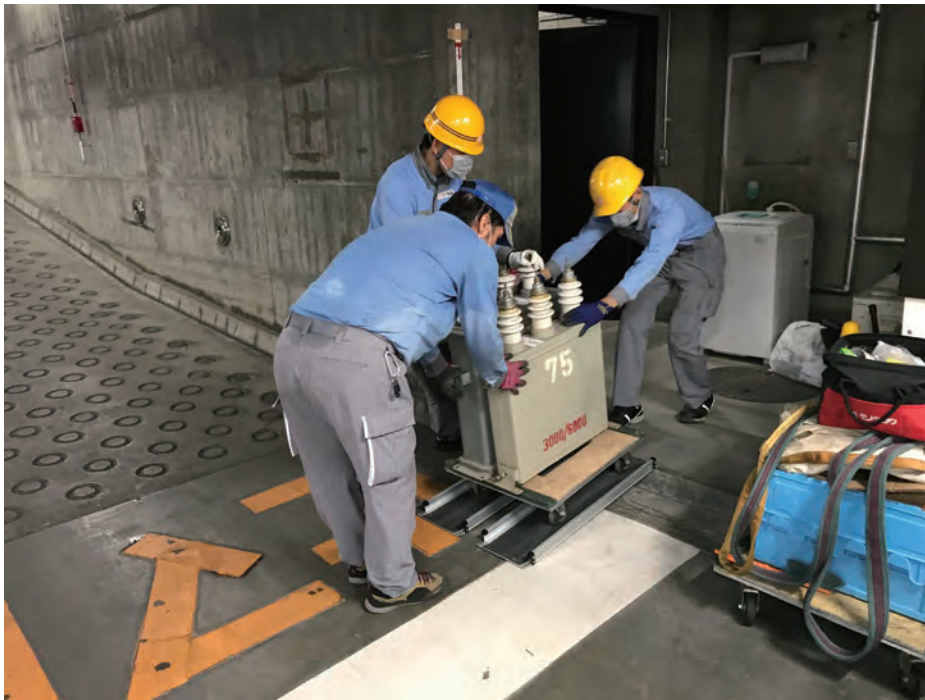
写真5-2 PCB廃棄物(高濃度コンデンサーの運搬処理)
