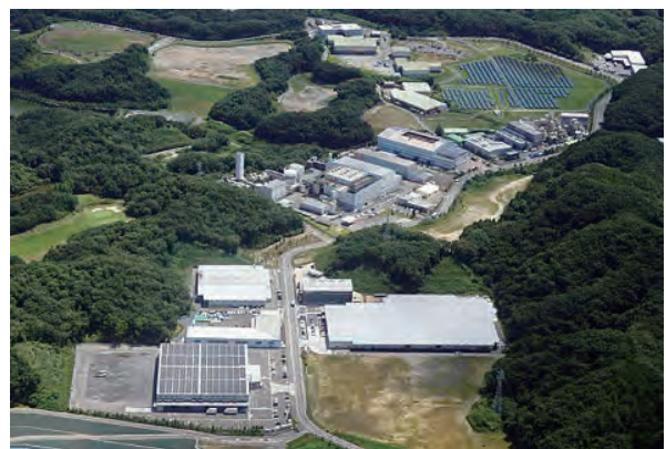
写真4-2 彩の国資源循環工場
