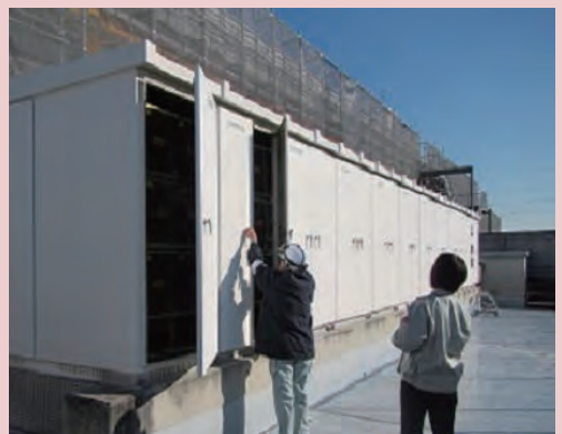
PCB廃棄物立入検査
