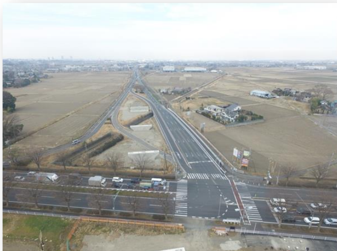
国道463号陸橋工事（富士見市）
