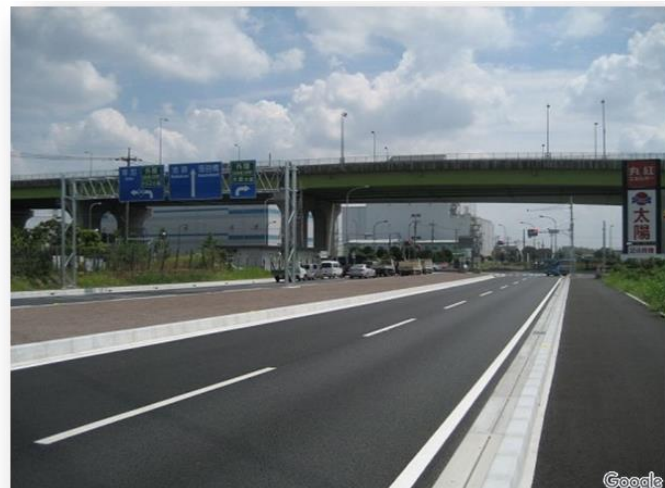
外環道付近完成区間（和光市）
