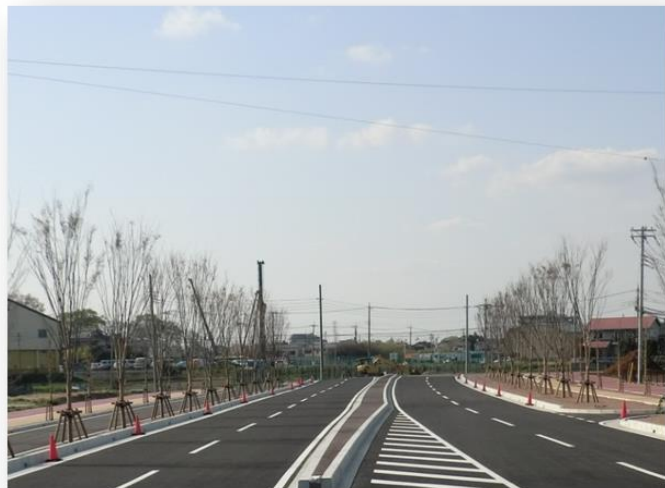
モデル工事区間（志木市）
