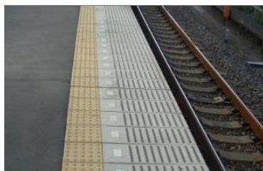
既存の点状ブロック
