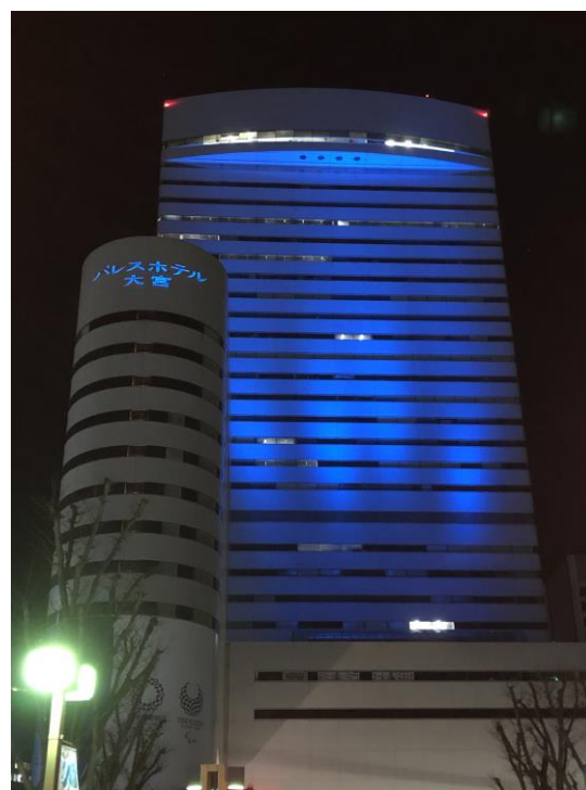
大宮ソニックシティビル（さいたま市） （令和2年4月5日（日）実施）
