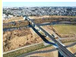
長大橋の建設
