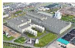
高度浄水処理施設(整備中)
