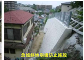
急傾斜地崩壊防止施設
