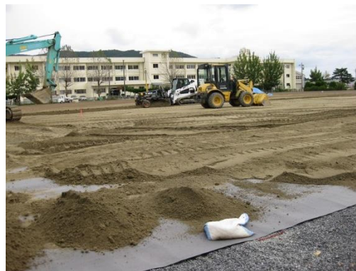
石巻市の復旧現場（公園）
