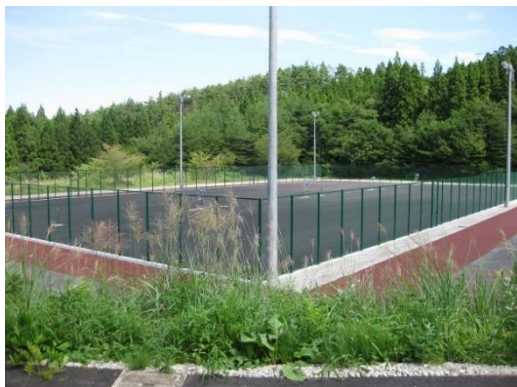
気仙沼市の復旧現場（テニスコート）
