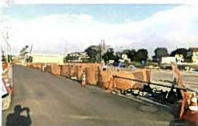
(仮称) 三郷流山橋への接続道路の工事・用地買収、三郷松伏線との交差点工事・電柱等の移設工事
