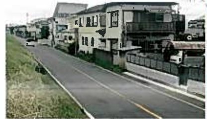
県道葛飾吉川松伏線 彦倉1丁目地内における舗装の修繕工事 800m
