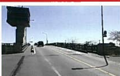
新大膳橋の橋面舗装等の修繕
