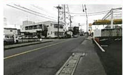
県道上笹塚谷口線 谷口地内における舗装の修繕工事 500m
