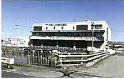
大場川上流排水機場におけるポンプの点検・修理等
