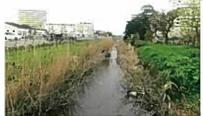
第二大場川 采女地内の樹木伐採・土砂の撤去
