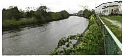
大場川 寄巻地内における堤防強化のための護岸工事
