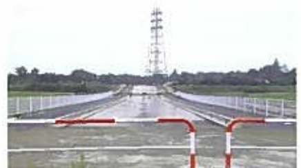
深谷市側から見た風景。小山川に架かる橋に向け道路の整備が進んでいます。
