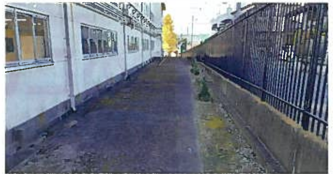
▲ 防災倉庫の設置予定地
