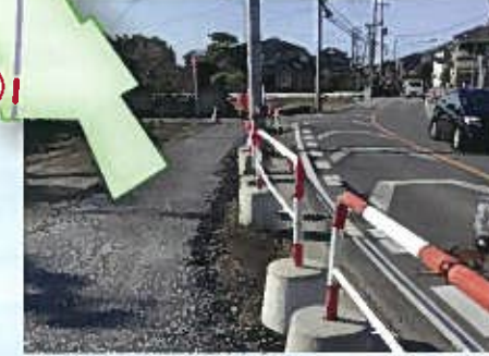
⑫ ⑭ 笠幡狭山線(宮沢橋付近)
