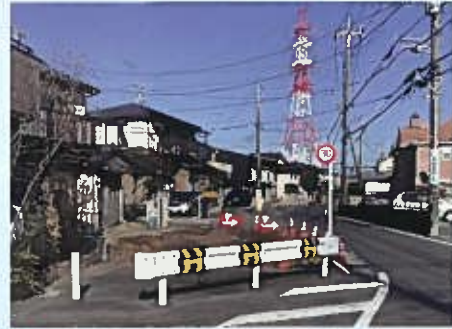
① 中新田入間川線(上奥富地内)
