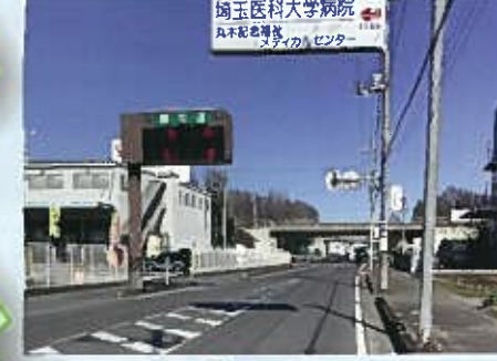
⑪ 日高狭山線(根岸地内)
