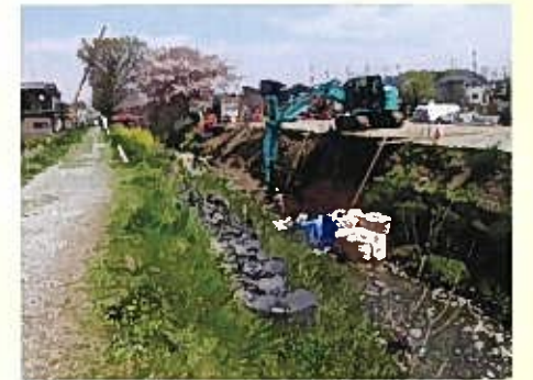
⑪ 不老川(新入曽橋下流)
