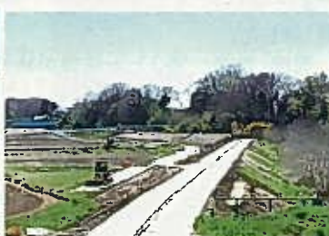
▲決壊箇所周辺の改良工事中の新江川
