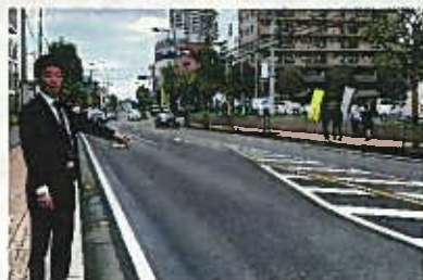
■県道266号の改修工事
