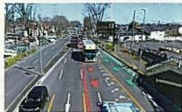
▲注意喚起のカラー舗装や右折レーンの延長工事が行われた東松山インター前
