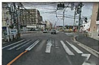
■上福岡駅前県道56号の拡幅工事
