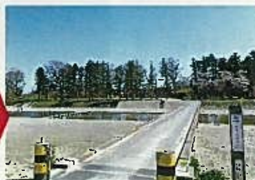
▲河道の復旧工事が行われ石段も敷設された都幾川鞍掛橋周辺
