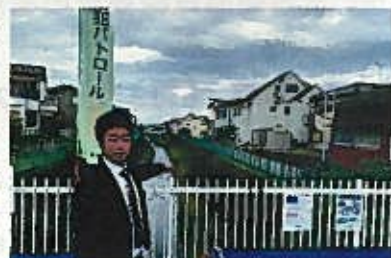
■砂川堀の改修工事
