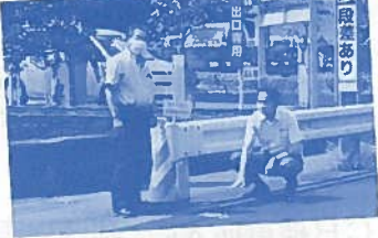
改修中の道路を確認する村岡(右)と井上市議(左)
